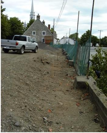
*Fig. 15 – 2001 - Travaux pour l'enfouissement des fils et l'installation d'une clôture en fer forgé.*
