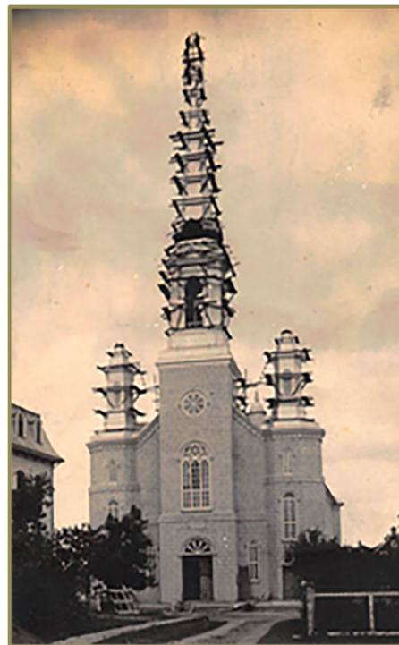
*Fig. 36 - 1923 - Réparations du clocher et des deux tours.*
