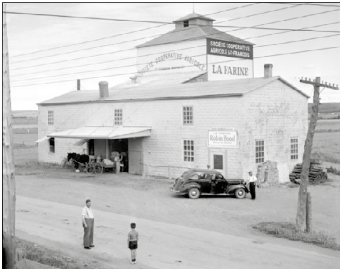
Le bâtiment de la Société coopérative agricole de Saint-François en 1948, photo Paul Boucher, BANQ.
