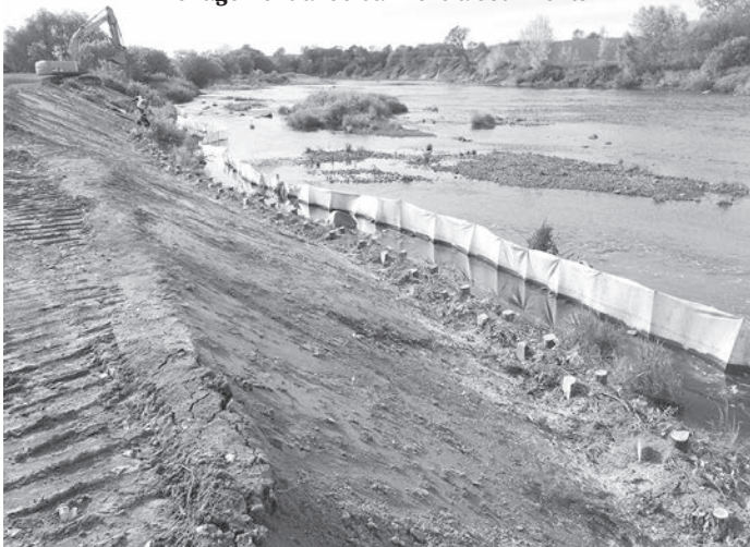
Aménagement avec barrière à sédiments
