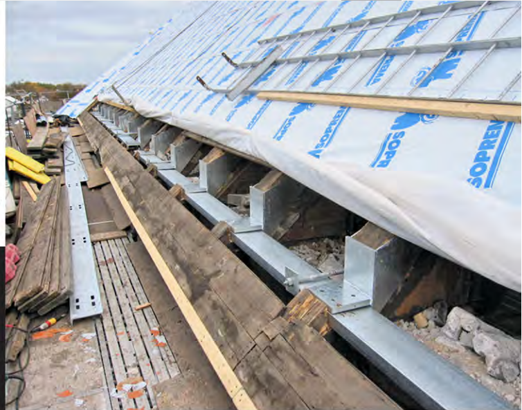
Travaux à la toiture de l'église
