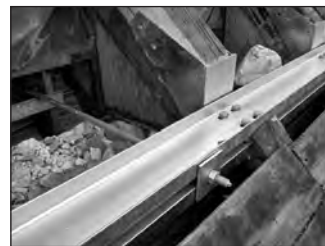
Photo 1 - Emboîtement, poutrelles en «C» et tirant 1 po. de diamètre au bas des chevrons.
