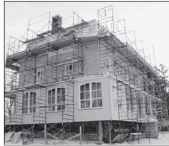
2014 - Début des travaux
