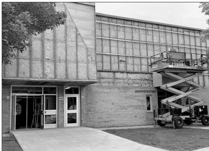
Des travaux d'infrastructures sont en cours de réalisation à l'école primaire La Francolière.
