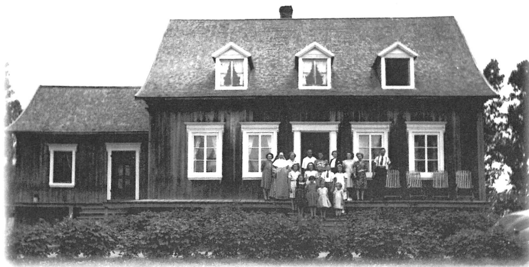
Photographie prise en 1947 avant les rénovations extérieures de la résidence.
