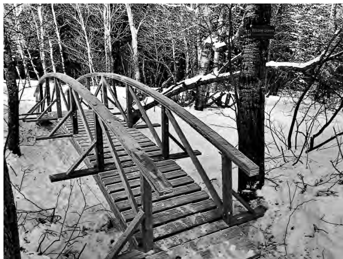
Le Pont Gilberte dans le secteur Cascades-de-la-Loutre à Sainte-Euphémie.
